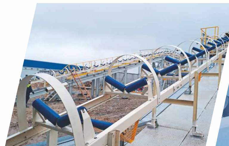
Монтаж галерейного конвейера, ЗАО «AzerFloat», Азербайджан, г. Сумгайыт
